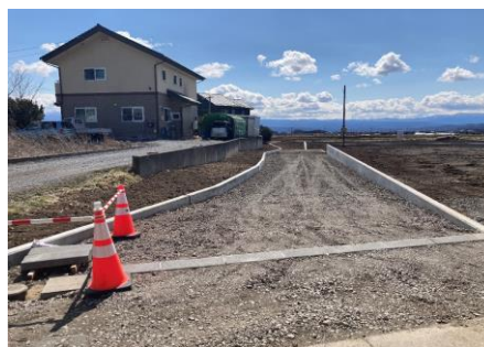
▲進入口。アスファルト舗装をして引き渡す。
